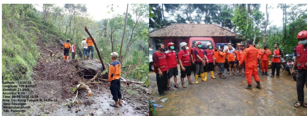
Gambar 2.20. Penanganan Tanah Longsor dan Briefing Tim SAR Penanganan Bencana
